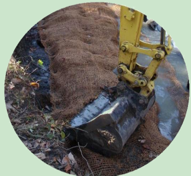
Installation de toile de coco
